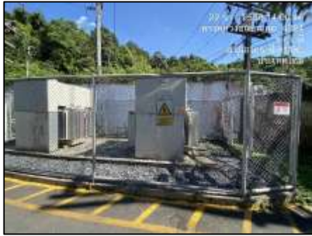
หม้อแปลงไฟฟ้า TR 1-2
